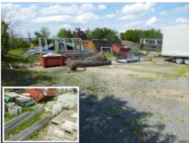
Abb. 6: Zwischengelagerte Baumaterialien am westlichen Rand der Schotterfläche und zeitweilige Parkplatznutzung
