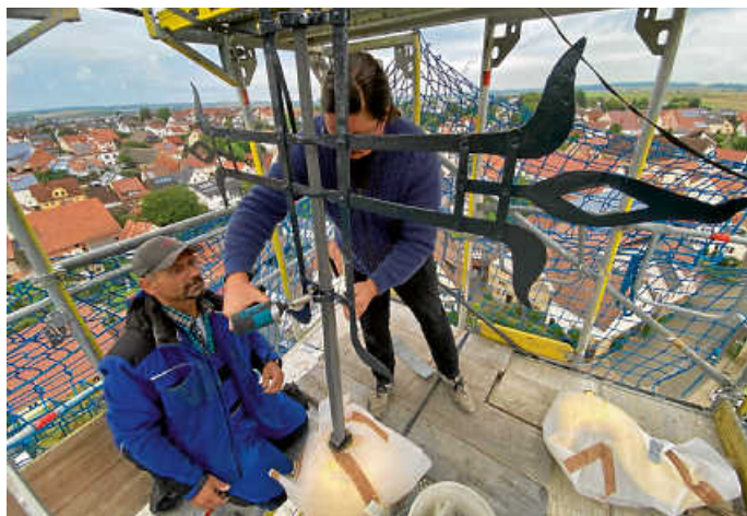
Das Flammenkreuz wird fest montiert.
